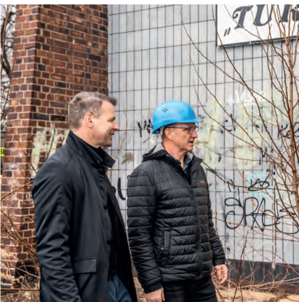
Die GWG-Vorstände Andreas Rißka (li.) und Holger Siebert (re.) bei einer Baustellenbegehung an der „Turbine“ © Steven Schwerdtner (2024)
