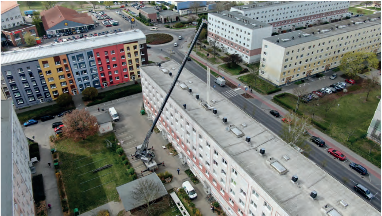
Einhub eines innenliegenden Personenaufzugs in ein Mehrfamilienhaus der GWG in der Alexander-von-Humboldt-Straße (Archivbild) © Xaa Media (2019)
